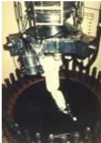
JPDR炉内構造物解体に適用
