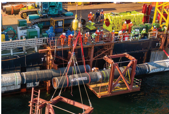
パイプライン「ノルドストリーム 2」建設作業 (2021 年 9 月撮影 提供：Nord Stream 2 AG/AFP/アフロ)
